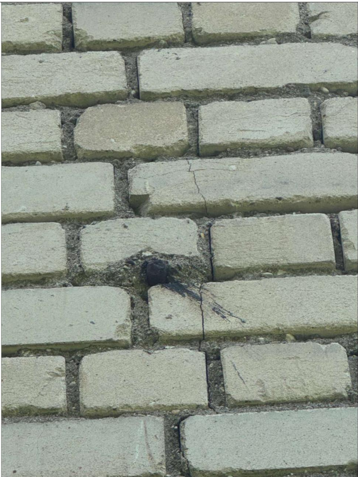
Atsivēre vertikālūs plyšiai
