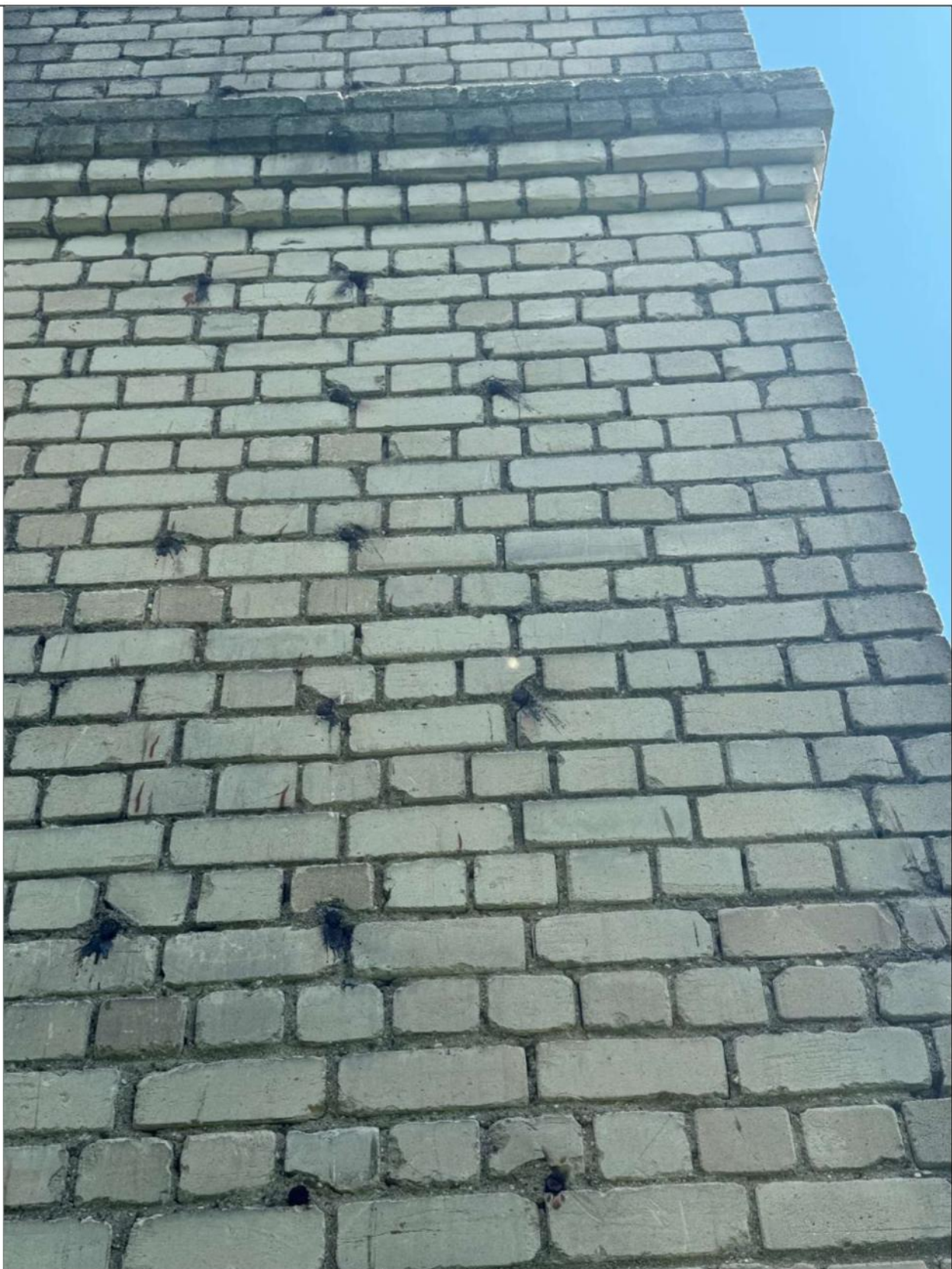
Atsivėrę vertikalūs plyšiai
