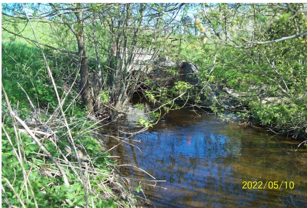
4.12 pav. PVP ištekėjimo dalis, apaugusi medžiais ir krūmais.
