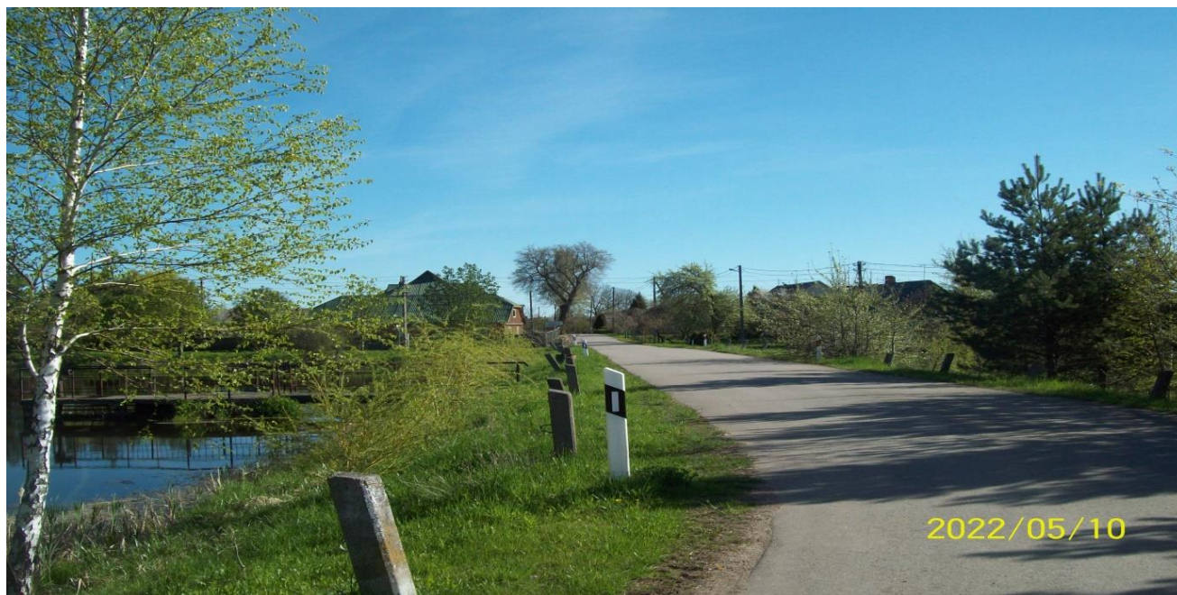
4.1 pav. I užtvankos ketera ir aukštutinis šlaitas.
