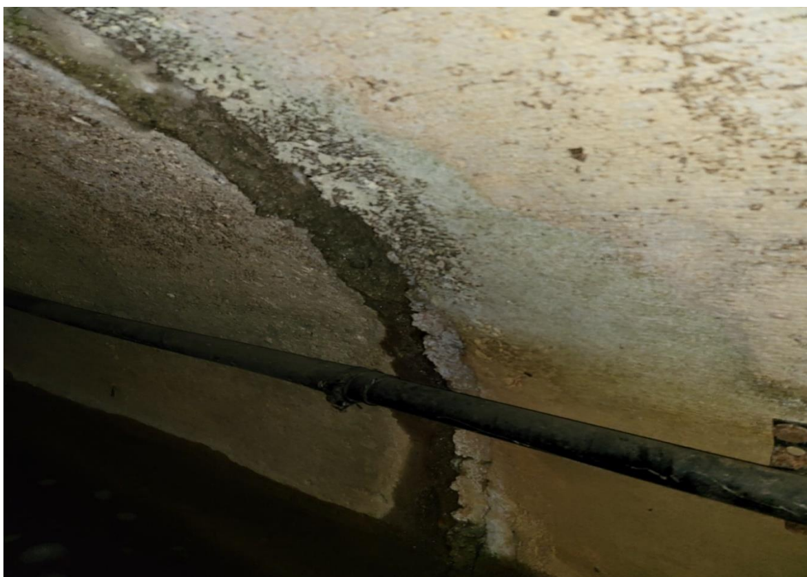
4.18 pav. PVP pratekėjimo dalies susiformavusios deformacijos vamzdžių sandūrose.
