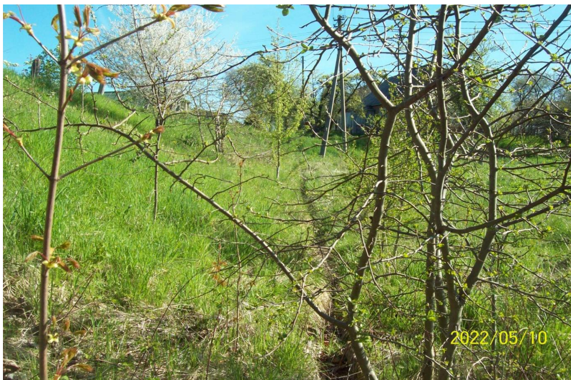
4.6 pav. Žemės užtvankos pašlaitės latakas.
