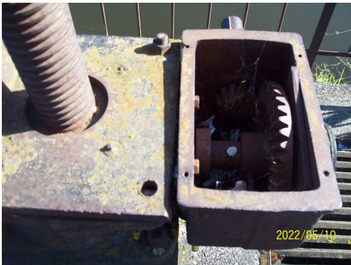
4.4 pav. Neveikiantis ir nuniokotas uždorių pakėlimo mechanizmas.
