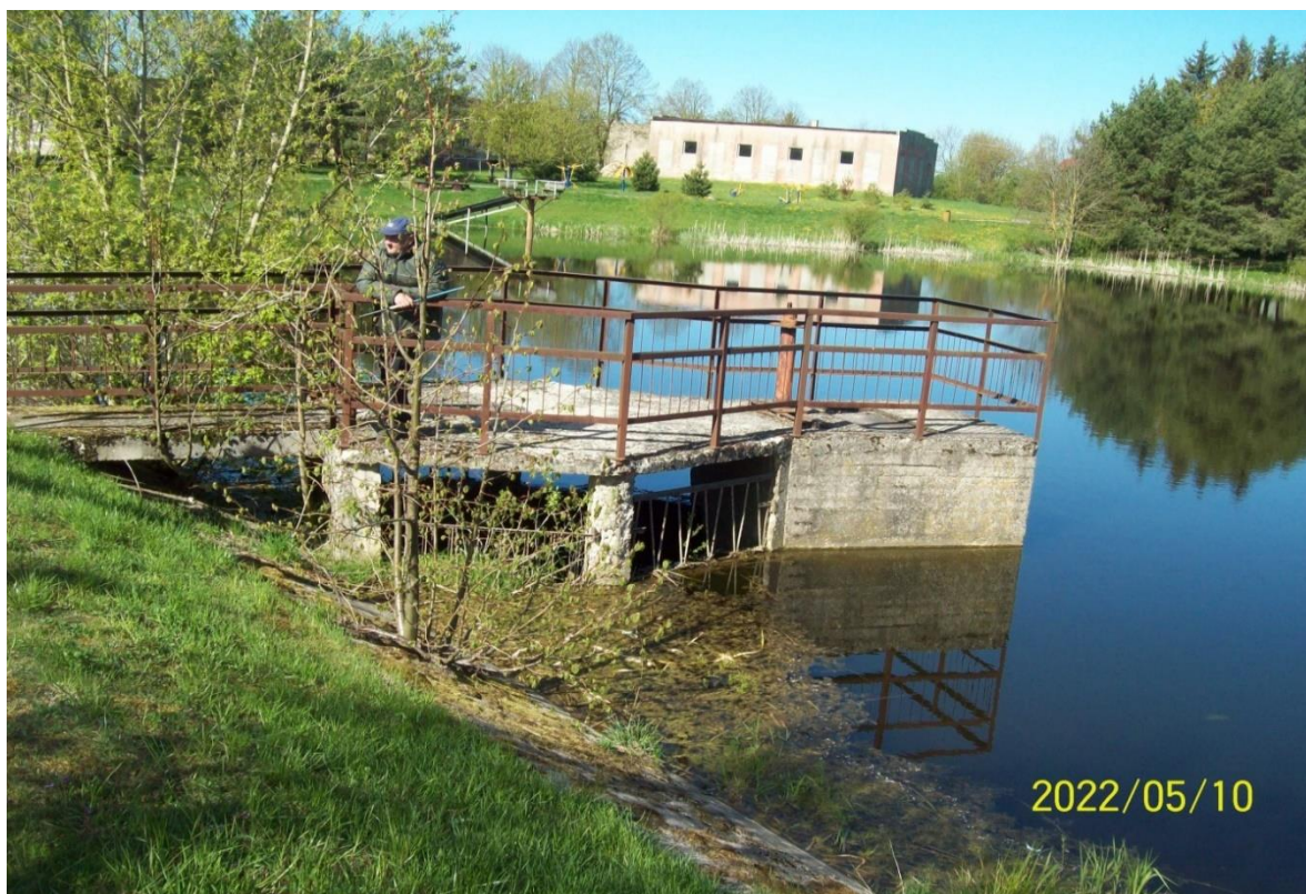
4.10 pav. Šachtinės PVP įtekėjimo dalis.
