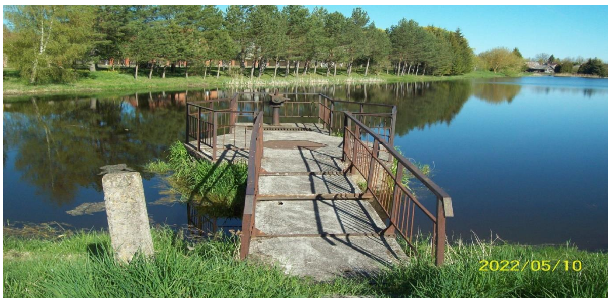
4.2 pav. Šachtinės PVP įtekėjimo dalies vaizdas.
