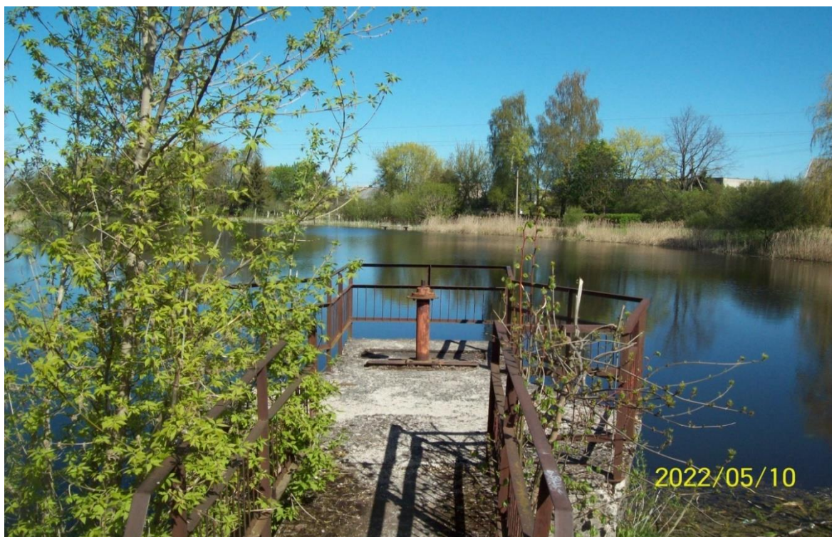
4.15 pav. Nuniokotas uždorio pakėlimo mechanizmas ir tiltelis paveiktas gamtinių veiksnių.
