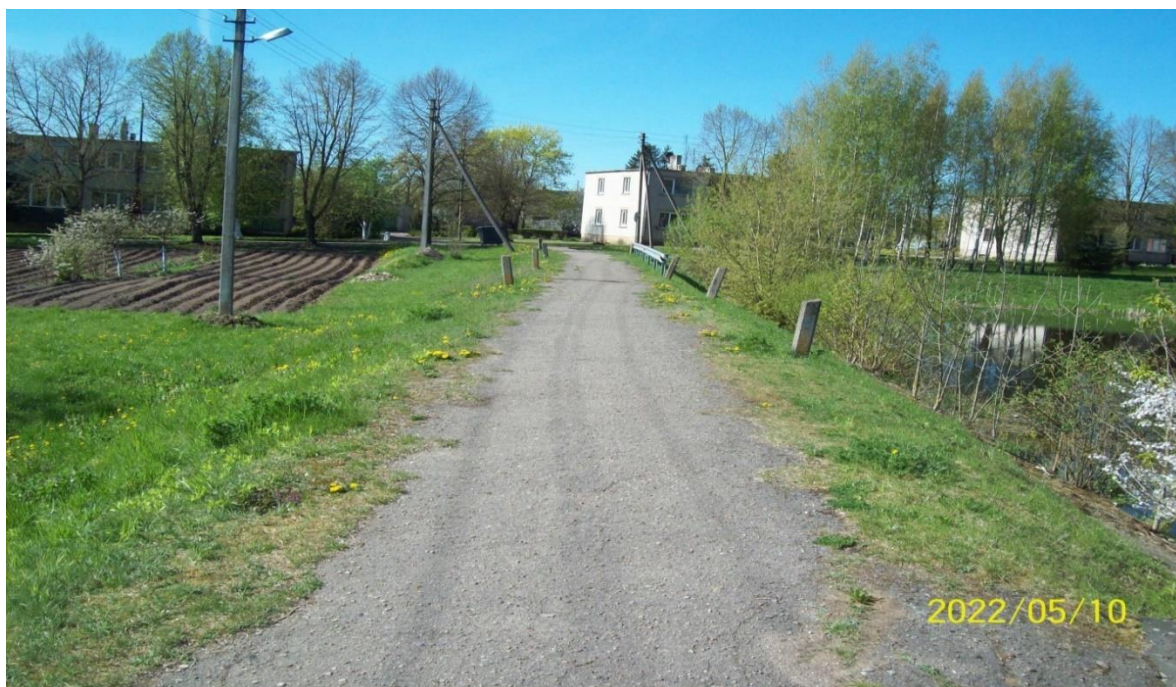
4.9 pav. ŽU keteroje įrengtas asfaltbetonio dangos pėsčiųjų takas.
