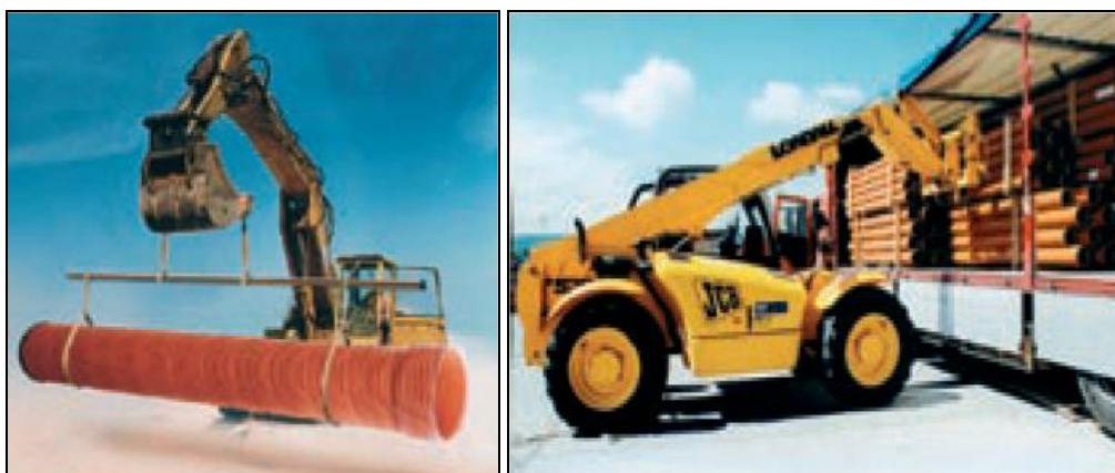
4 paveikslas. Mechanizuotas vamzdžių krovimas
