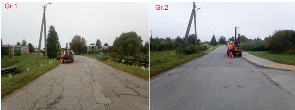
1 pav. Lauko darbai
