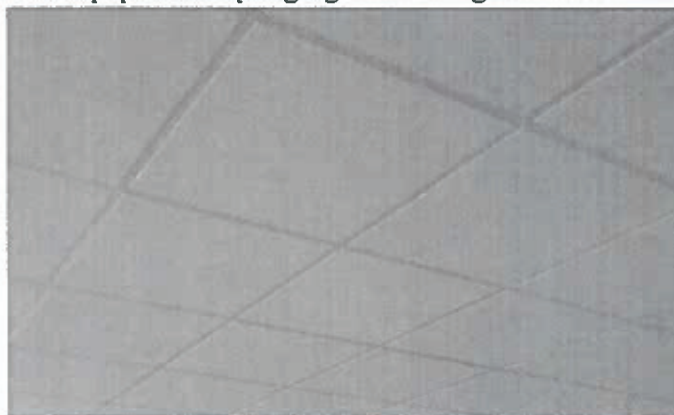
21 pav. Segmentinės lubos su pusiau paslėptu profiliu
