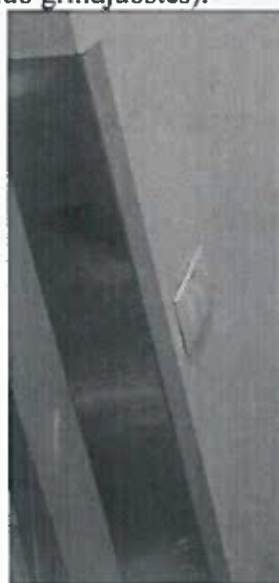
17 pav. Išorinių kampų aptaisymas metaliniais kampuočiais
