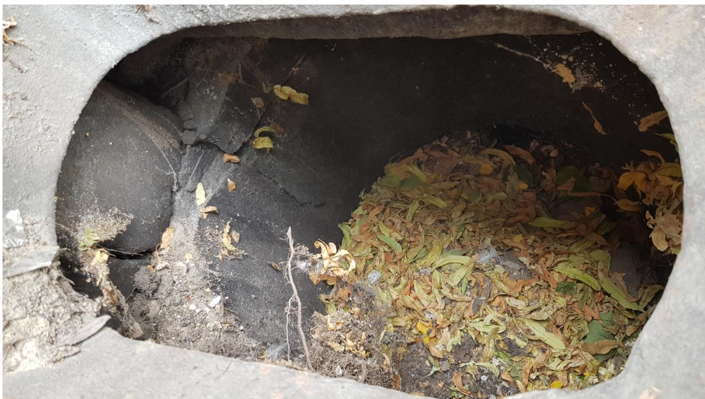
Paviršinių nuotekų surinkimo šulinėlis 28.95a1 seno tipo, be nuosėdų surinkimo dalies. Būklė bloga.
