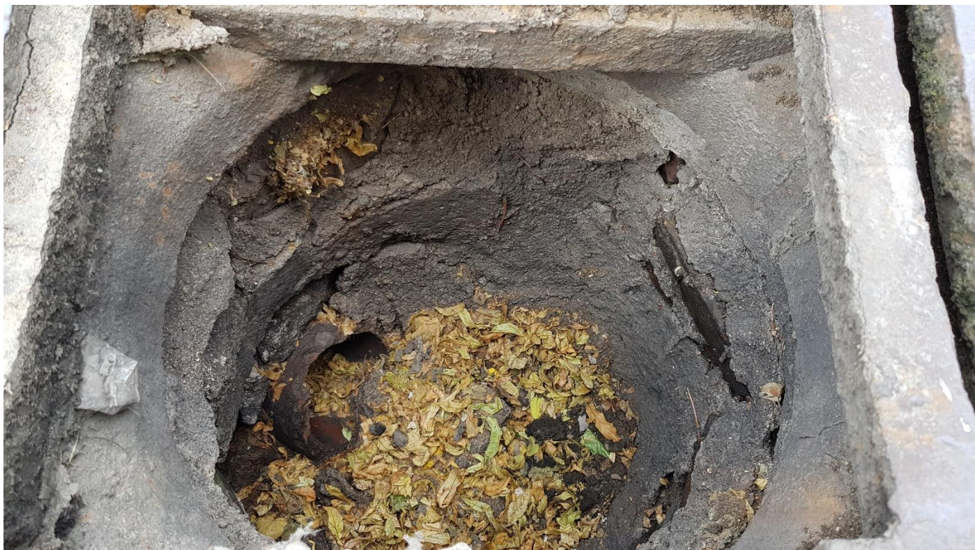
Paviršinių nuotekų surinkimo šulinėlis 66.95a1 seno tipo, be nuosėdų surinkimo dalies. Būklė bloga.
