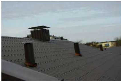
Esami alsuokliai iškeli virš stogo.
