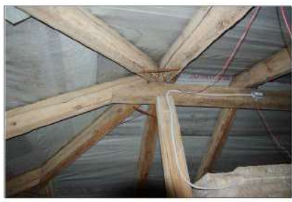
Esamas stogo kraigas pilnai uždarytas antikonkondensacine plėve.
