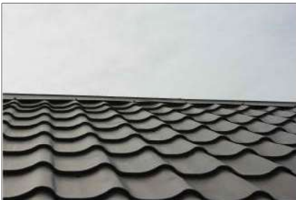
Esamas stogo kraigas pilnai uždarytas.
