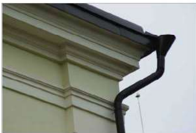
Esamas kamizas pagrindiniame Igoninės komplekso pastate. Kamizo profilis naudojamas restauracijoje, kaip analogas iš to paties komplekso.
