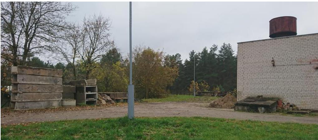
Pav. 2. Demontuojama dalis betono dangų ir perkeliama apšvietimo atrama (tolumoje).
