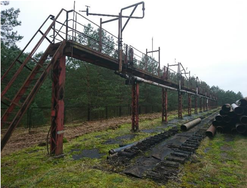
Pav. 1. Demontuojami statiniai: Mazuto išpylimo estakada, unik. Nr. 4400-2862-3565 ir geležinkelio bėgių latakai.
