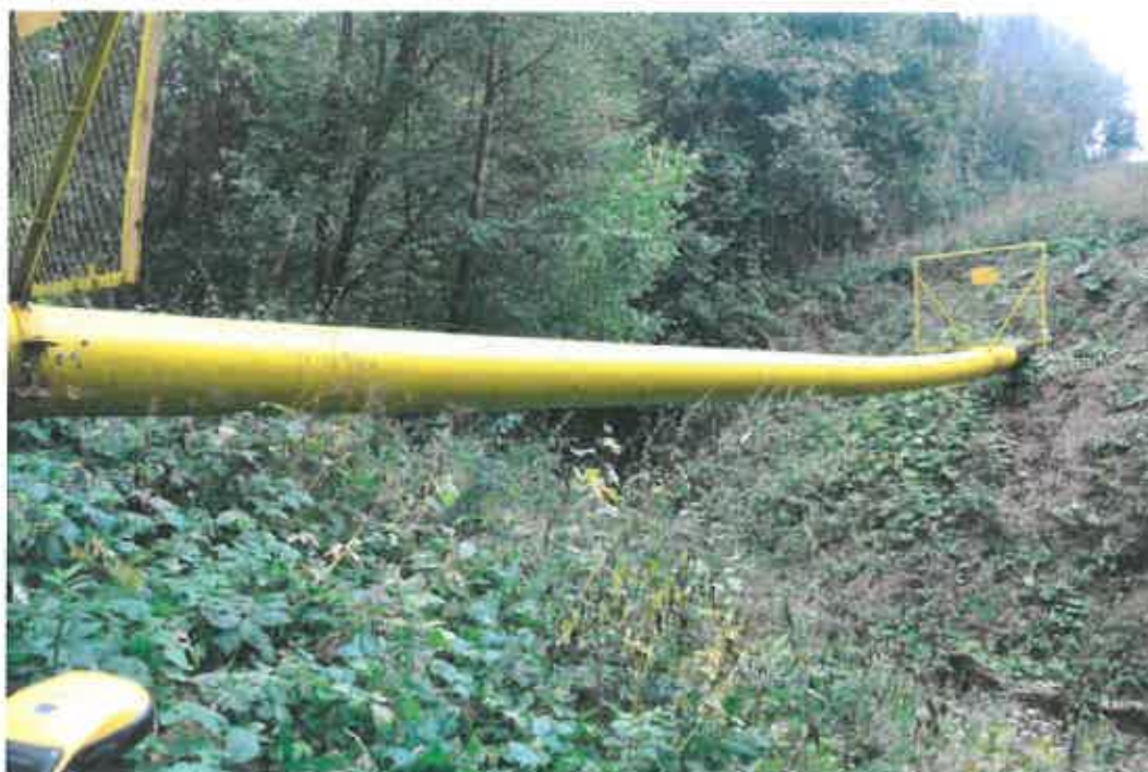
Pav. 4. MD atšakoje į Alytaus DSS DN400 antžeminė perėja per kanalą: X:519398,32; Y:6075154,80; PK58+80
