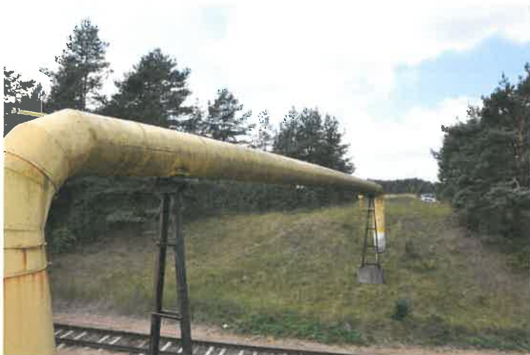
Pav. 4. MD atšakoje į Alytaus DSS DN400 antžeminė perėja per kanalą: X:519398,32; Y:6075154,80; PK58+80
