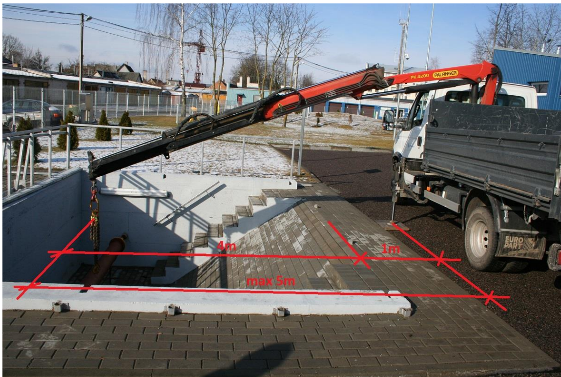
8 pav. Hidraulinio krano pasiekiamumas ir atstumai, kai iškasa nesutvirtinta .
