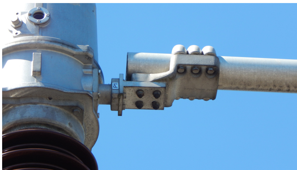
14.2 pav. 110 kV L-Biruliškės (esamas operatyvinis pavadinimas L-Kruonio HAE) prijunginio 110 kV srovės matavimo transformatorių esamas aparatinis gnybtas surenkamų šynų prijungimui
