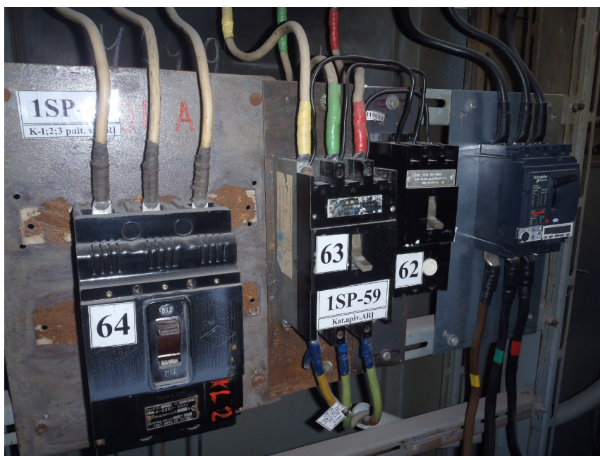
Komutacinė įranga sumontuota atvirai.
