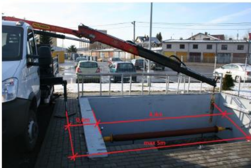
7 pav. Hidraulinio krano pasiekiamumas ir atstumai, kai iškasa sutvirtinta .
