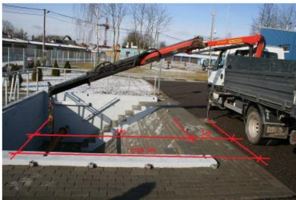
8 pav. Hidraulinio kranio pasiekiamumas ir atstumai, kai iškasa nesutvirtinta .
