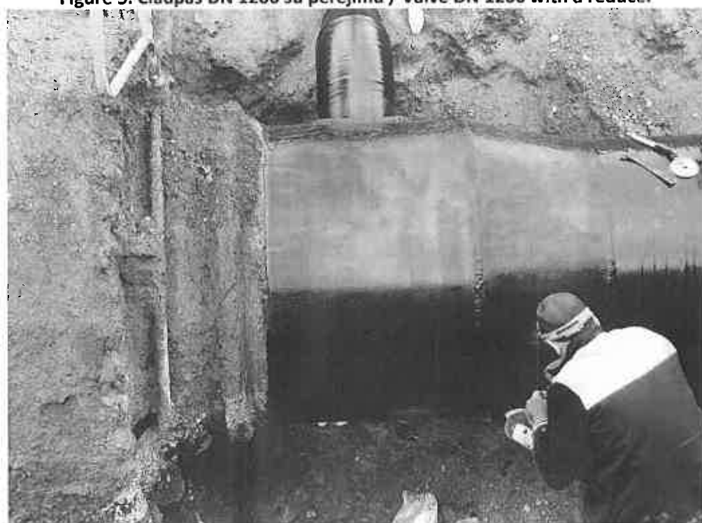
Figure 6. Čiaupas DN 1200 su perėjimu / Valve DN 1200 with a reducer
