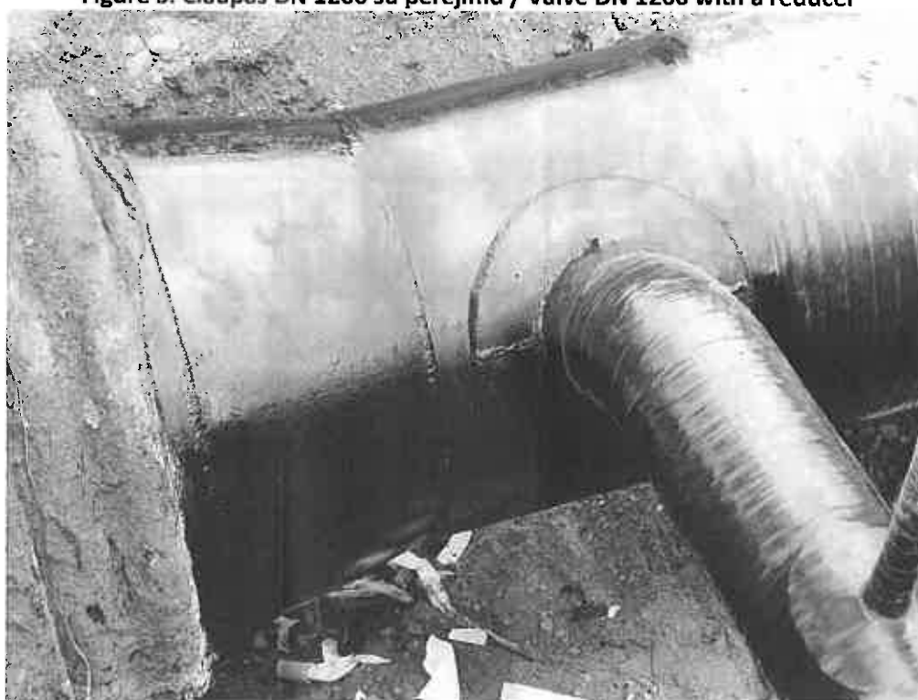
Figure 4. Čiaupas DN 1200 su perėjimu / Valve DN 1200 with a reducer
