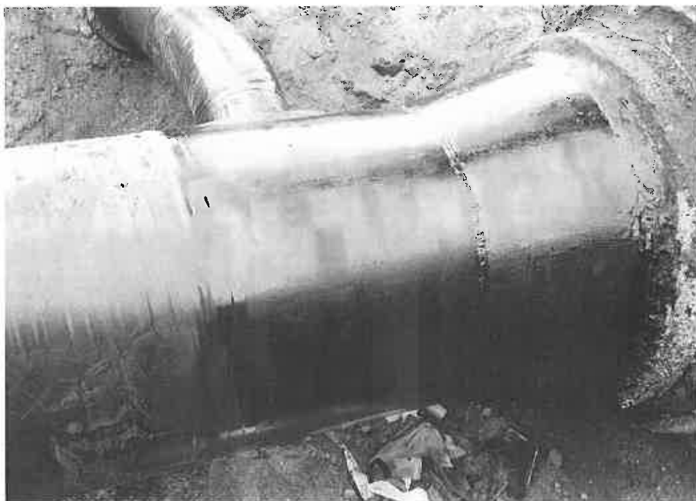
Figure 5. Čiaupas DN 1200 su perėjimu / Valve DN 1200 with a reducer
