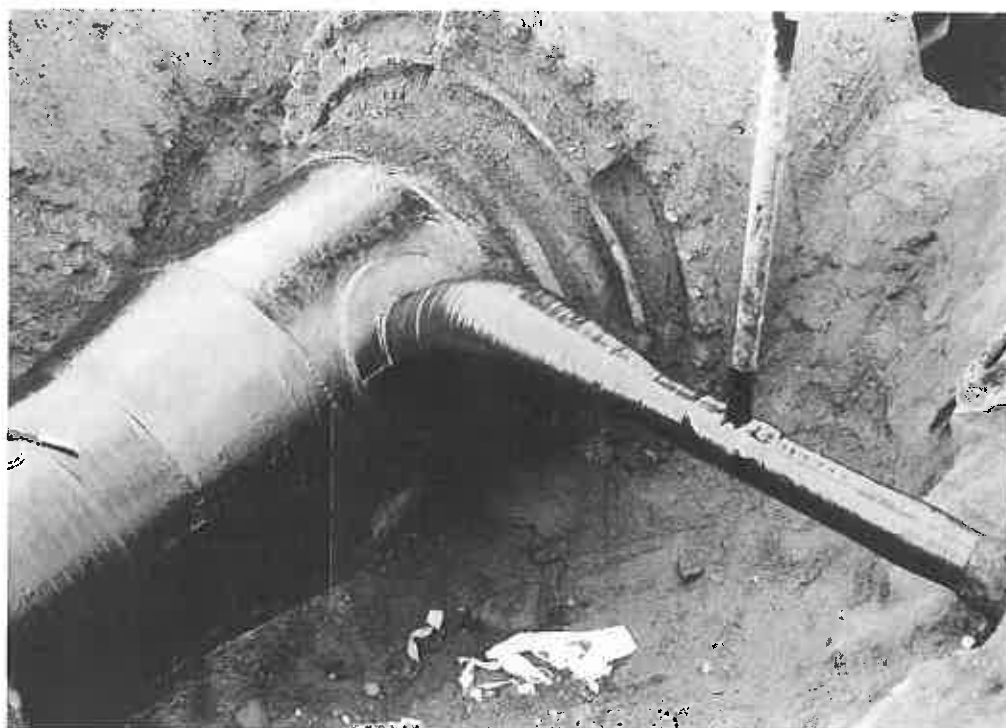
Figure 3. Čiaupas DN 1200 su perėjimu / Valve DN 1200 with a reducer
